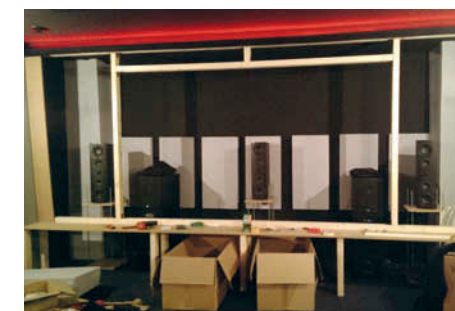
Hinter die Frontbühne kamen die Boxen und viel Basotect-Schalldämmung.
