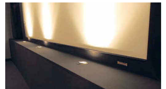
Drei Halogenstrahler in der Frontbühne beleuchten die schalltransparente, 2-fach maskierbare Leinwand von Xodiac.
