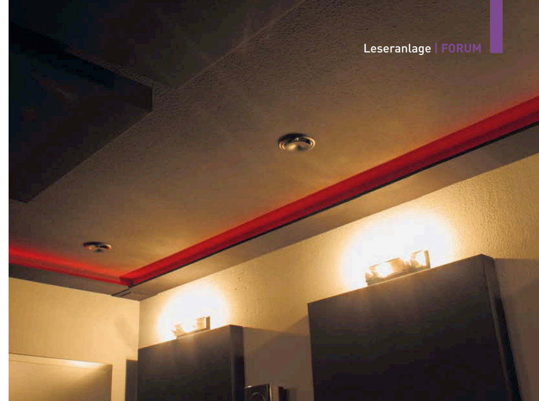
Das Deckenfries aus Holz wurde mit schwarzem Stoff beklebt. In die Einbuchtung wurde ein LED-Band verlegt, das wahlweise rot, blau oder grün leuchtet. Hinzu kommen Halogen-Spots über den Absorbern.
